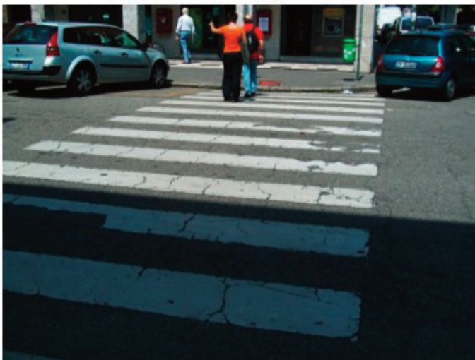
prima degli interventi
