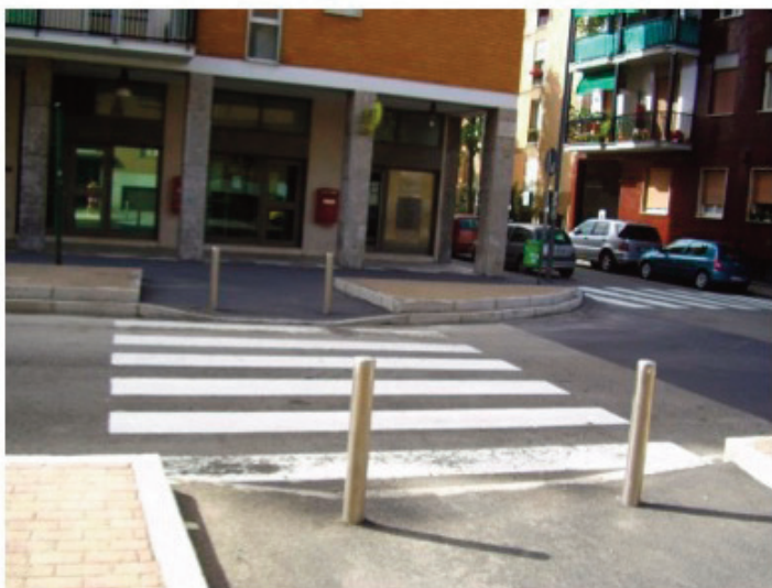
dopo gli interventi
